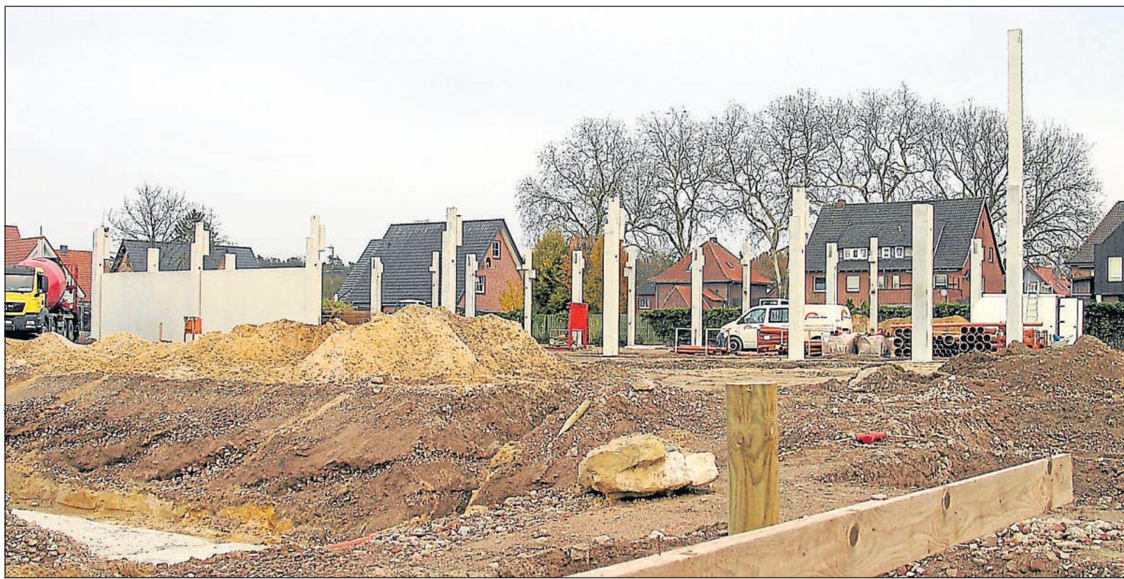
Zügige Fortschritte sind momentan für das Vorhaben Schlösserweg zu beobachten. Beim Bau der Märkte auf der 10 500 Quadratmeter großen Fläche kommt nach Auskunft des Architekten Andreas Grube ein hoher Anteil vorgefertigter Elemente zum Einsatz. Bild: Schäfer
